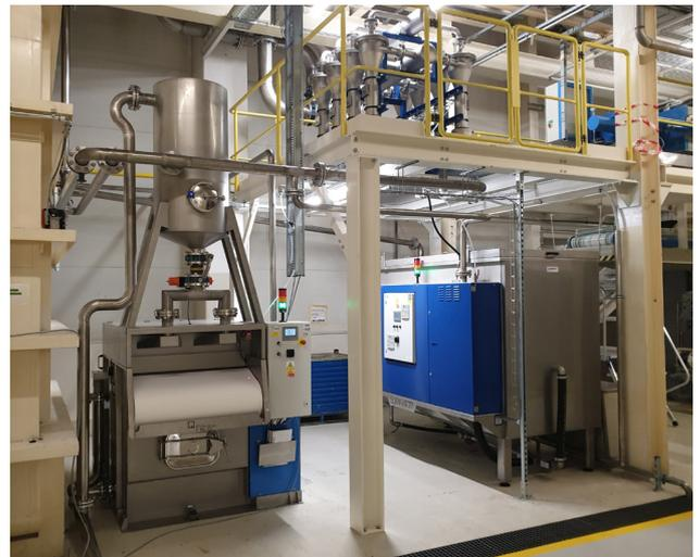
Ein typischer Aufbau für die Badpflege bei der Vorbehandlung in einer Automobil-Lackierlinie mit Suparator® und Q-Filter®.
